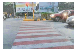
कि डिजाइनिंग के स्तर पर राजमार्गों के काम शामिल हैं। इंजीनियरिंग के पहलुओं के लिए इंडियन रोड कांग्रेस संहिता के अलावा भारत में सड़क सुरक्षा के लिए प्रवर्तन और आपातकालीन देखभाल को लेकर कुल मिलाकर एकसमान मानक नहीं है। एक अधिकारी ने कहा, 'इस समय अधिकारी सिर्फ इंजीनियरिंग के पहलुओं की जांच करते हैं, लेकिन हम कुल मिलाकर
